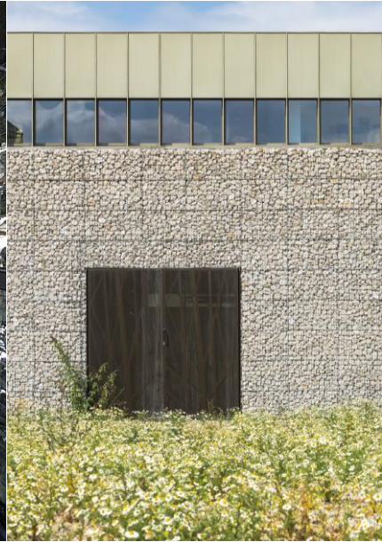
Gabion et Végétation
