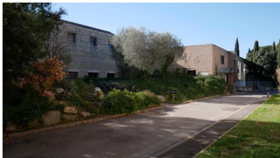
Accès Nord et vue du bâtiment cuisine.
