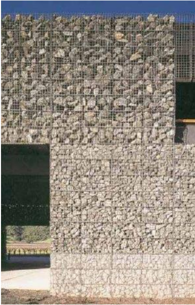
Voiles en Gabion
