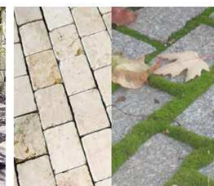
Dallage en pavés de pierre naturelle
