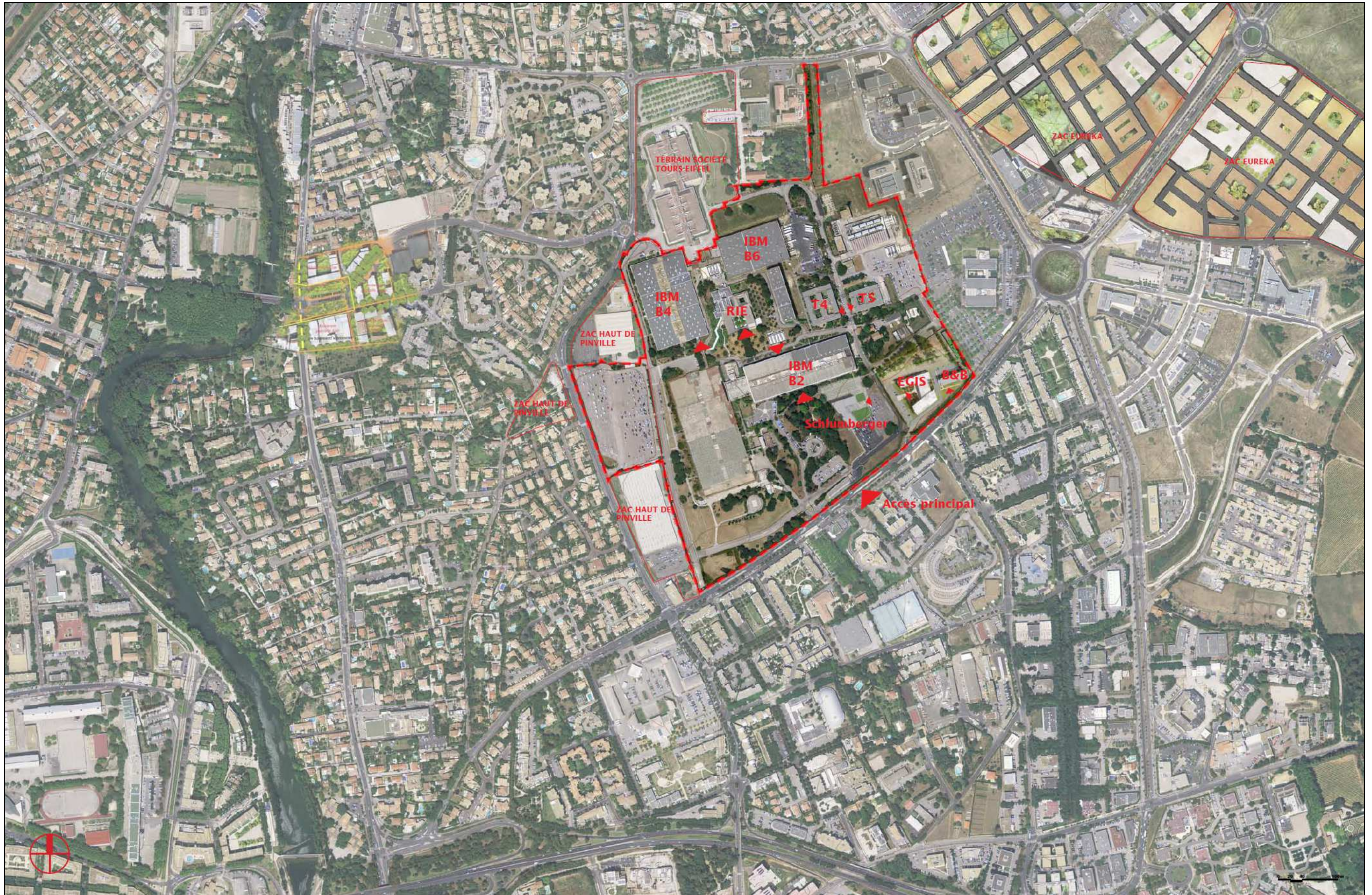
Figure 4 : Vue aérienne du site d'étude (Source : Plan guide, Janvier 2017)
