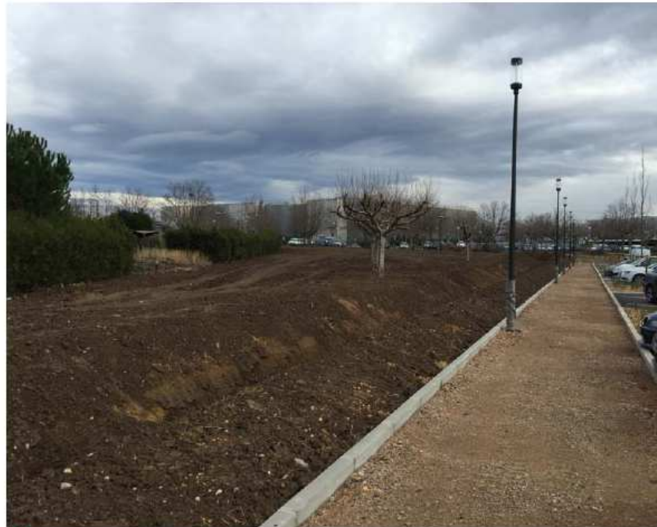
12 Espace en restructuration
