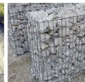
Remplissage de gabions
